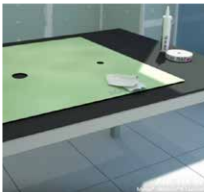
CORRECT : ACTIVATEUR DE SURFACE
