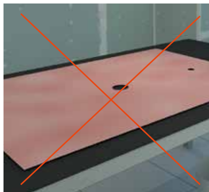
INCORRECT : AUCUN ACTIVATEUR DE SURFACE
