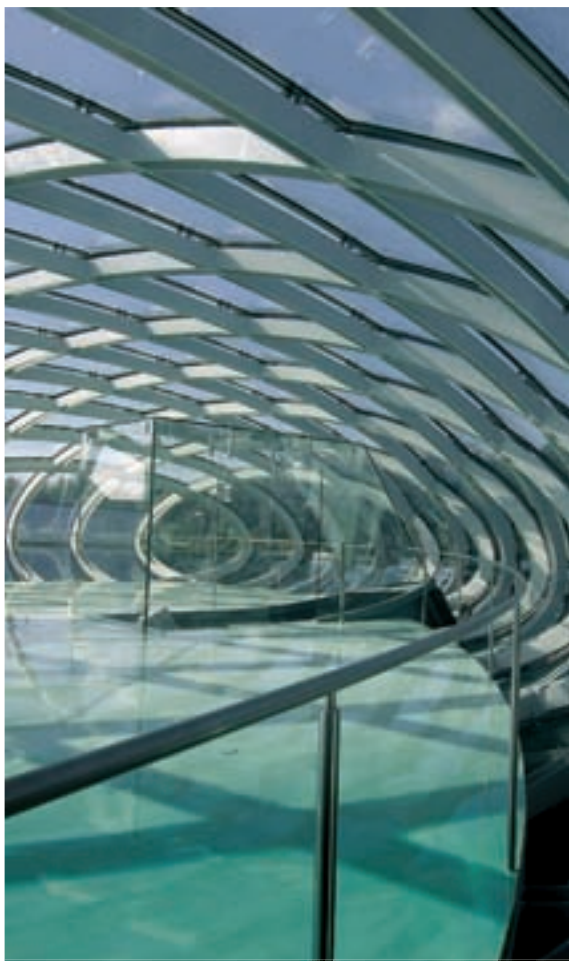
„Bolle” – Nardini Distilleries – Ośrodek badawczy – Bassano del Grappa, Italy – Architekt: M. Fuksas – Sunergy Clear z Planibel Green
