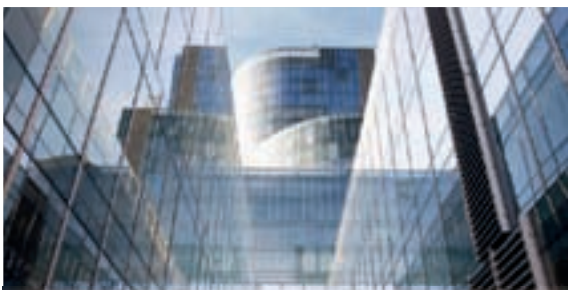
Torre Gas Natural – Barcelona, Španělsko – Architekt: Enric Miralles a Benedetta Tagliabue – Stopsol Supersilver Grey a Classic Clear
