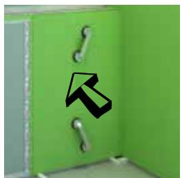
**11** Utilice perfiles metálicos en las esquinas externas para mejorar la resistencia.
