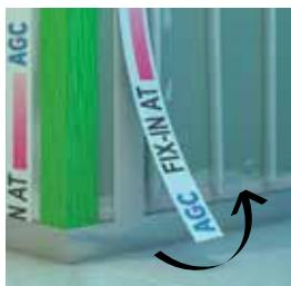
**9** Empiece la instalación por el canto externo. Posicione y ajuste la hoja de vidrio mientras flota sobre la silicona.
