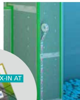
**6** Aplique la silicona FIX-IN SL en líneas verticales<sup>(1)</sup> o puntos sobre la pared, respetando las distancias recomendadas (ver la tabla más abajo), en función del espesor del vidrio.
