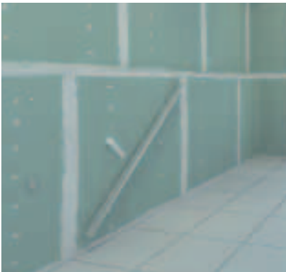
OCENA ŚCIANY POD KĄTEM NIERÓWNOŚCI
