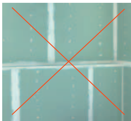
ŹLE: BRAK PODKŁADU GRUNTUJĄCEGO
