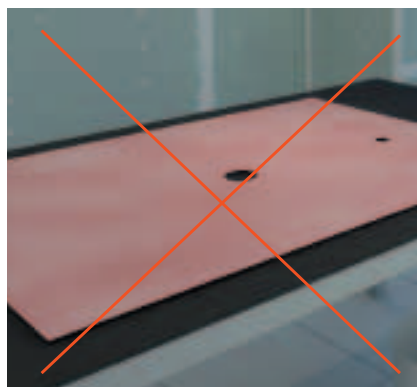
ŹLE: BRAK AKTYWATORA POWIERZCHNI PRZED NAŁOŻENIEM SILIKONU
