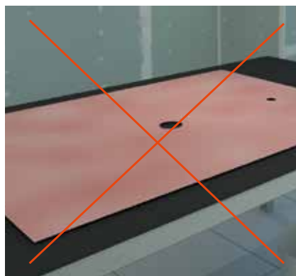
SBAGLIATO: SILICONE SENZA ATTIVATORE SUPERF.
