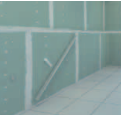
MĚŘENÍ ROVINNOSTI ZDI
