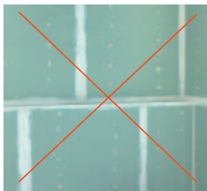
ŠPATNĚ: CHYBÍ STĚNOVÁ PENETRACE
