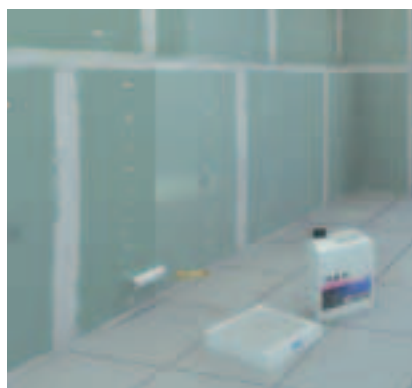
DOBRCZE: PODKŁAD GRUNTUJĄCY
