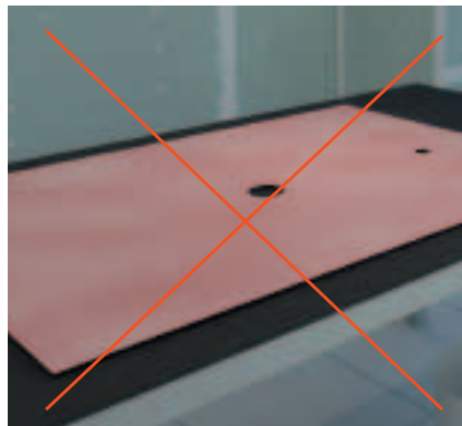
ŹLE: BRAK AKTYWATORA POWIERZCHNI PRZED NAŁOŻENIEM SILIKONU
