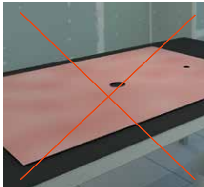
INCORRECT : AUCUN ACTIVATEUR DE SURFACE
