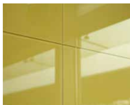
JOINTS COMBLÉS À L'AIDE D'UN SILICONE
