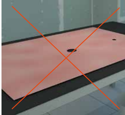
FALSCH: KEIN SILIKON-OBERFLÄCHENPRIMER
