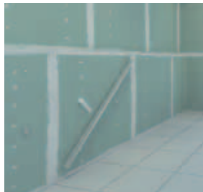
MĚŘENÍ ROVINNOSTI ZDI
