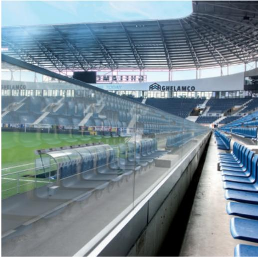
Stratobel Strong ist ein Verbund-sicherheitsglas mit einer im Vergleich zu herkömmlichen PVB-Folien wesentlich belastbareren Spezial-Folie. Diese verfügt über verbesserte mechanische Eigenschaften und über eine besonders neutrale Optik, wodurch die Farbwirkung der Verglasung erhalten bleibt, zum Beispiel in Verbindung mit dem besonders hellen, eisenarmen Planibel Clearvision von AGC.
