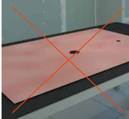
FALSCH: KEIN SILIKON-OBERFLÄCHENPRIMER
